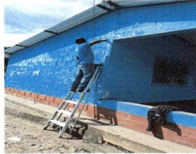
FOTO 2: Pintura en muros exteriores e interiores
