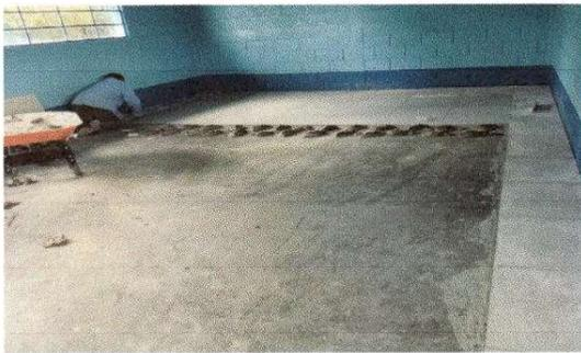
FOTO 3: Sustrucción de piso de torta de concreto
